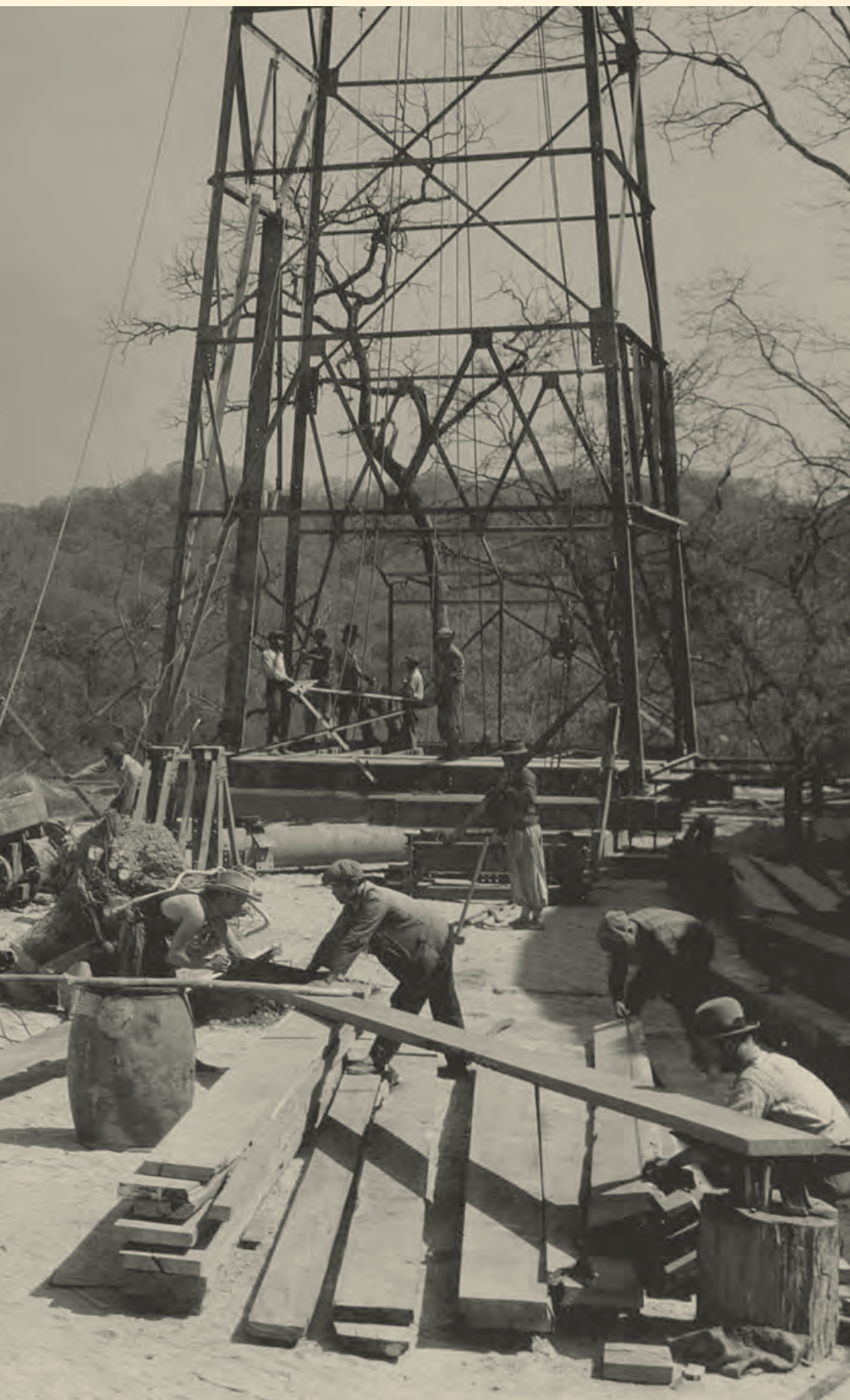
« Trabajos de instalación de un pozo. (Campo Durán, Salta, 1934)
