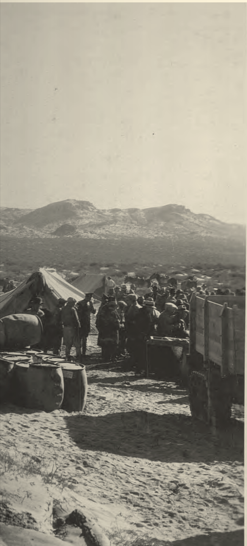
« Instalación del primer pozo petrolero en Potrerillos. (Mendoza)
